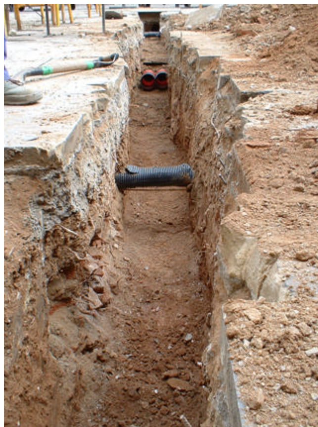
Fotografia 6: Vista parcial de la Rasa 200.
