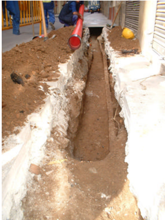
Fotografia 3: Vista parcial de la Rasa 100.
