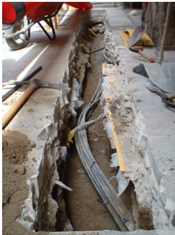
Fotografia 4: Vista parcial, amb nombrosos serveis anteriors, de la Rasa 100.
